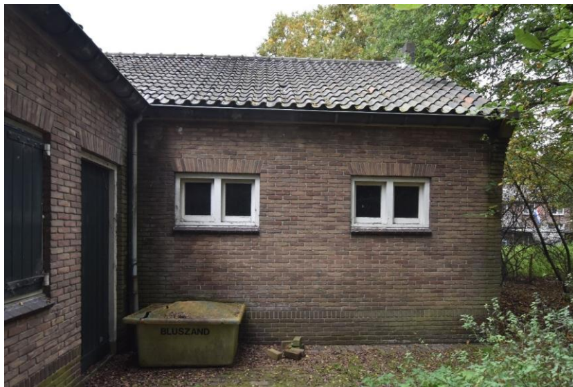
Gebouw 10. De zuidgevel van het middendeel van het gebouw. De indeling is sinds de bouw ongewijzigd gebleven.
