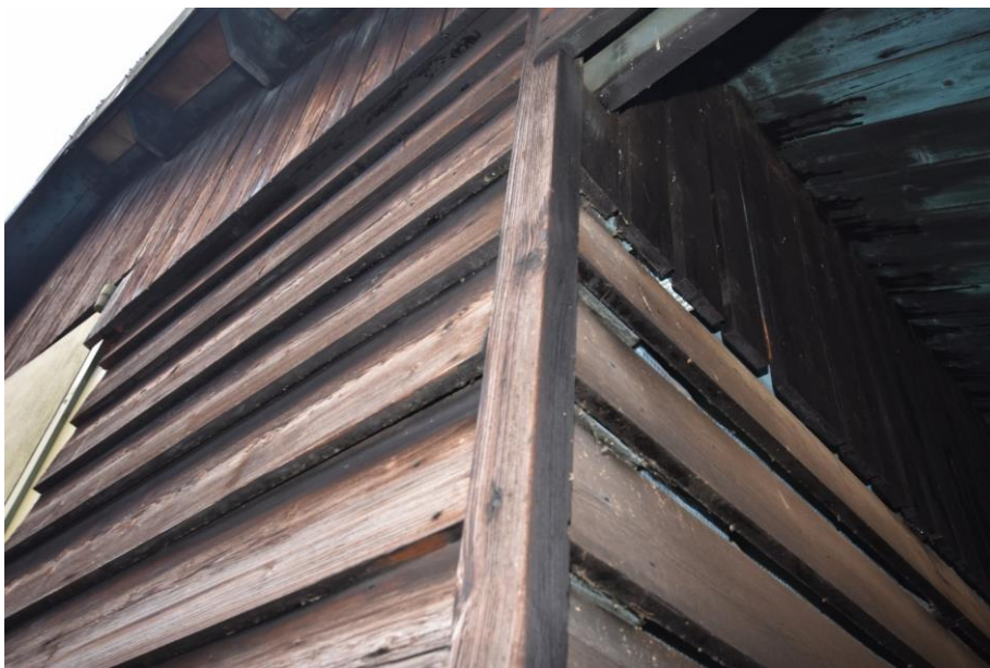
Gebouw 12. Detail van het houtwerk. Rechts de langsgevel met de rabatdelen die zo geplaatst zijn dat er 2 cm tussenruimte tussen de delen is, zodat de loods goed geventileerd kon worden. Er boven zijn verticaal geplaatste latten van 9,5 cm breed aangebracht, op een gemiddelde onderlinge afstand van 2,5 cm. Links is de gevel als gesloten potdekselwerk uitgevoerd. Het geheel is uitgevoerd, zoals het beschreven staat in het bestek,
