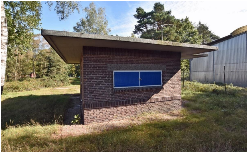
Gebouw 14. Overzicht van de westgevel van het gebouw.
