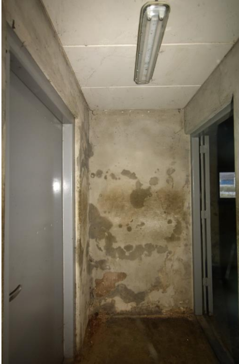
Gebouw 14, ruimte 01. Het toegangsportaal van de oefenruimte. Links de toegang tot het gebouw en rechts de doorgang naar de eigenlijke gaskamer.
