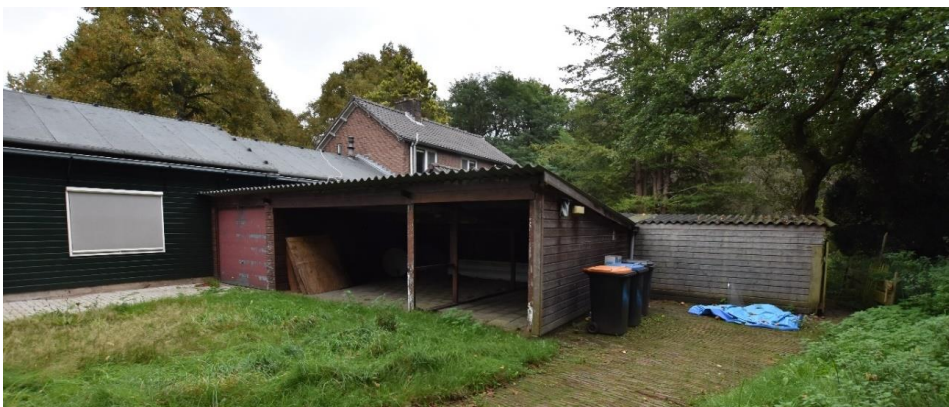
Gebouw 9. Overzicht van de houten overkapping die eind vorige eeuw tegen de zuidgevel van de loods is geplaatst.
