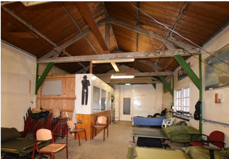
Gebouw 9. Overzicht van de schijvenloods gezien in oostelijke richting. Links de in het laatste kwart van de 20ste eeuw ingebouwde keuken zichtbaar. De kopse wand is de oude eindgevel van wat nu het tussenlid is.
