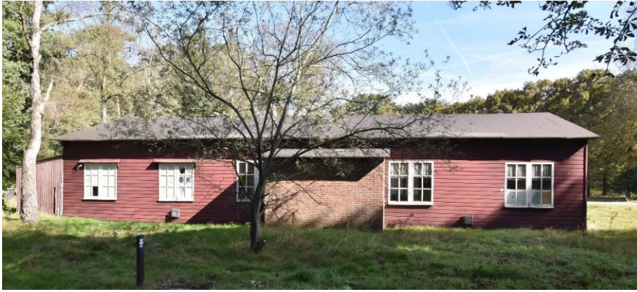
Gebouw 11. Overzicht van de westgevel. De bakstenen toiletuitbouw in het midden van de gevel is in de naoorlogse periode (rond 1967) toegevoegd.
