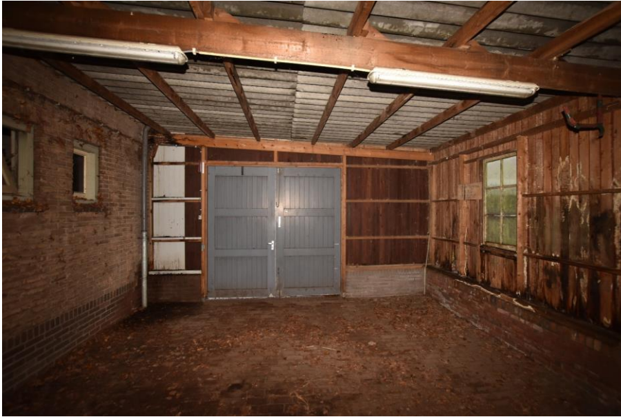
Gebouw 10, ruimte 7. Overzicht van de aanbouw gezien in noordelijke richting. De wanden zijn uitgevoerd met stijl- en regelwerk. De toegang wordt gevormd door een dubbele deur.
