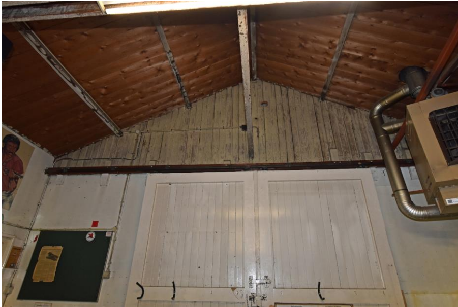
Gebouw 9. Detail van de topgevel van de loods. Te zien is dat de wand aan de binnenzijde is voorzien van wit geschilderde messing- en groefdelen. Dit zal de oorspronkelijke afwerking van het hele interieur van de loods zijn.
