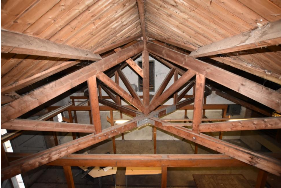
Gebouw 10, ruimte 2. Overzicht van de twee kruislings op elkaar geplaatste hangspanten ter plaatse van de centrale opslagruimte. De spanten zijn naderhand voorzien van ijzeren versterkingen.
