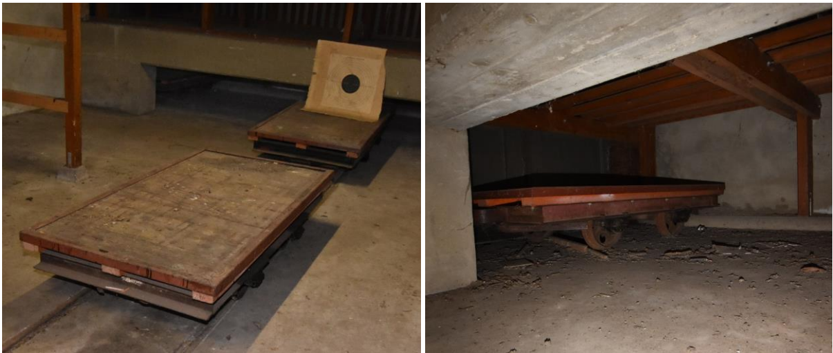
Gebouw 10, ruimte 2. In deze ruimte bevinden zich nog drie lorrys behorend bij het smalspoor. Twee van de drie zijn ook in het midden van de vorige foto zichtbaar. De derde bevindt zich onder de vloer van de houtopslag achterin ruimte 2.
