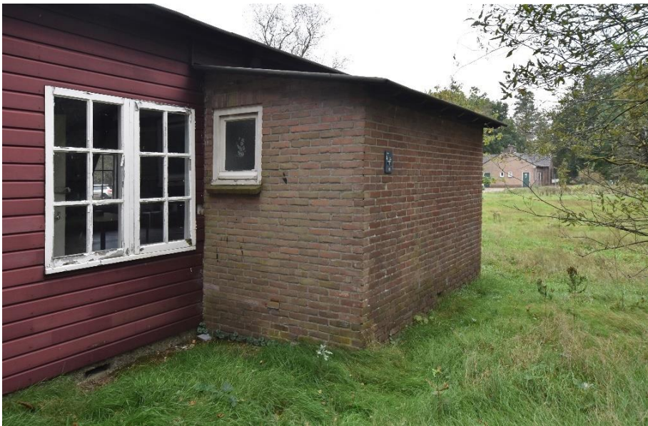
Gebouw 11. Detailopname van de rond 1967 toegevoegde toiletuitbouw. In het metselwerk is aan de koppen de plaats van de twee binnenwanden te herkennen.
