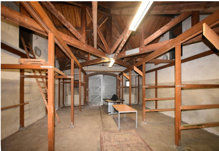
Gebouw 10, ruimte 2. De centrale opslagruimte gezien in de richting van de dubbele toegangsdeur. De beplanking van die deuren is vermoedelijk niet meer oorspronkelijk.
