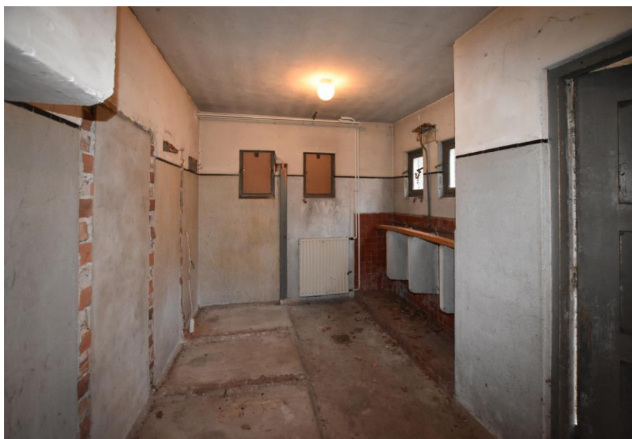
Gebouw 10, ruimte 5. Bij het manschappentoilet zijn de scheidingsmuren tussen de toiletten verwijderd. De nog aanwezige interieuronderdelen stammen uit de bouwtijd. Rechts zijn de urinoirs te zien.
