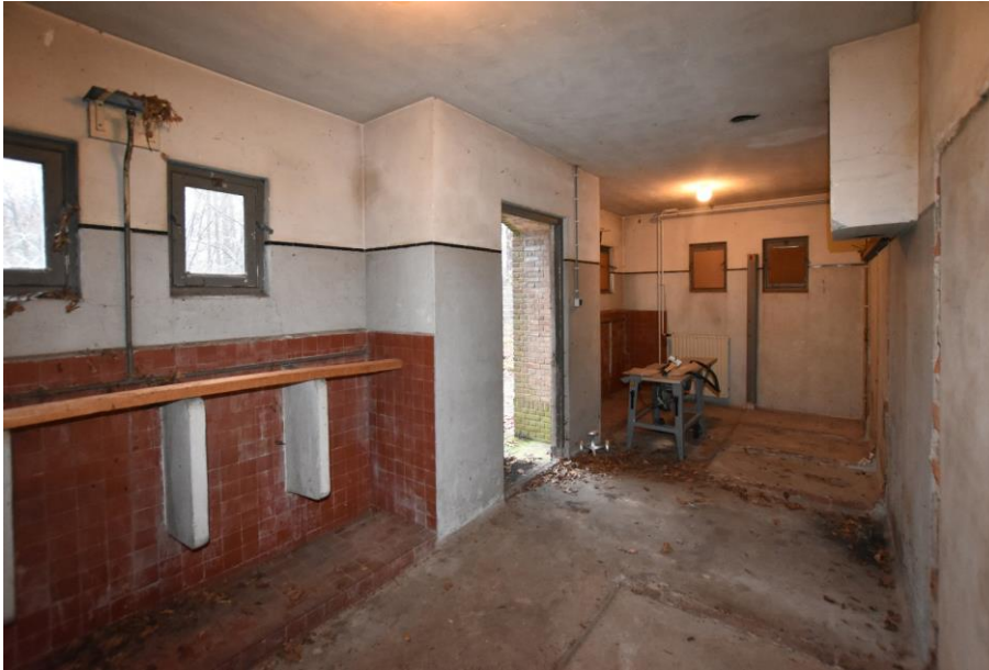
Gebouw 10, ruimte 5. Het manschappentoilet gezien in westelijke richting. Links de nog intacte urinoirs. Aan de andere zijde van de toegangsdeur zijn de tussenschotten verwijderd. Het uitkragende metselwerk rechtsboven op de foto is een rookkanaal dat behoort bij de inmiddels verwijderde kachel van het vertrek.
