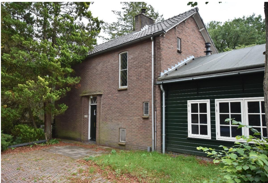
Gebouw 9. Overzicht van de noordgevel van het woongedeelte. De gevel is inclusief deuren en ramen vrijwel geheel oorspronkelijk. Het kleine venster vlak boven het maaiveld is thans afgedekt met plaatmateriaal.
