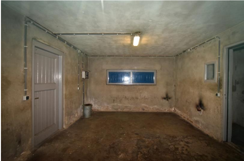
Gebouw 14, ruimte 02. Overzicht van de maskeroefenruimte, gezien naar het oosten.
