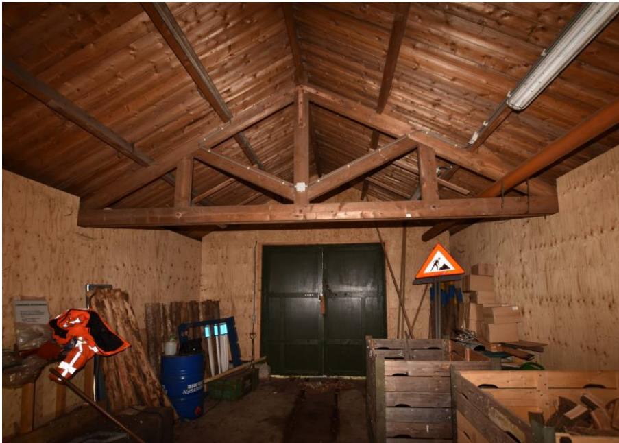
Gebouw 12. Overzicht van interieur van de lattenloods, gezien naar het oosten. De dubbele deur zal nog tot de oorspronkelijke opzet behoren. Het hangspant is versterkt met ijzeren beugels. De multiplex wandbeplating is relatief recent aangebracht.
