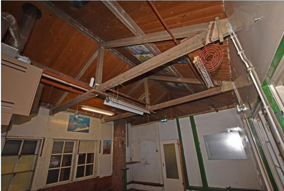
Gebouw 9. Zicht op de drie eenvoudige hangspanten, die de dakconstructie van het tussenlid vormen. Twee van de drie spanten zijn hier goed zichtbaar het derde bevindt zich ter plaatse van de westelijke kopgevel en is door een op het spant gespijkerd doek grotendeels aan het zicht onttrokken.
