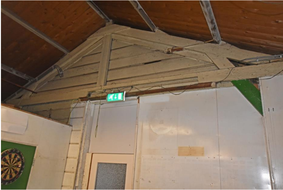
Gebouw 9. Detail van de oostelijke wand van de lods. De lods is tegen de oude eindgevel van het tussenlid geplaatst. Hierdoor is die buitengevel een binnenwand geworden. Dit zal relatief kort na de bouw van het tussenlid hebben plaatsgevonden. De aanwezige verflagen kunnen dus inzicht geven in de gevelafwerking van de oudste fase(n) van het tussenlid.
