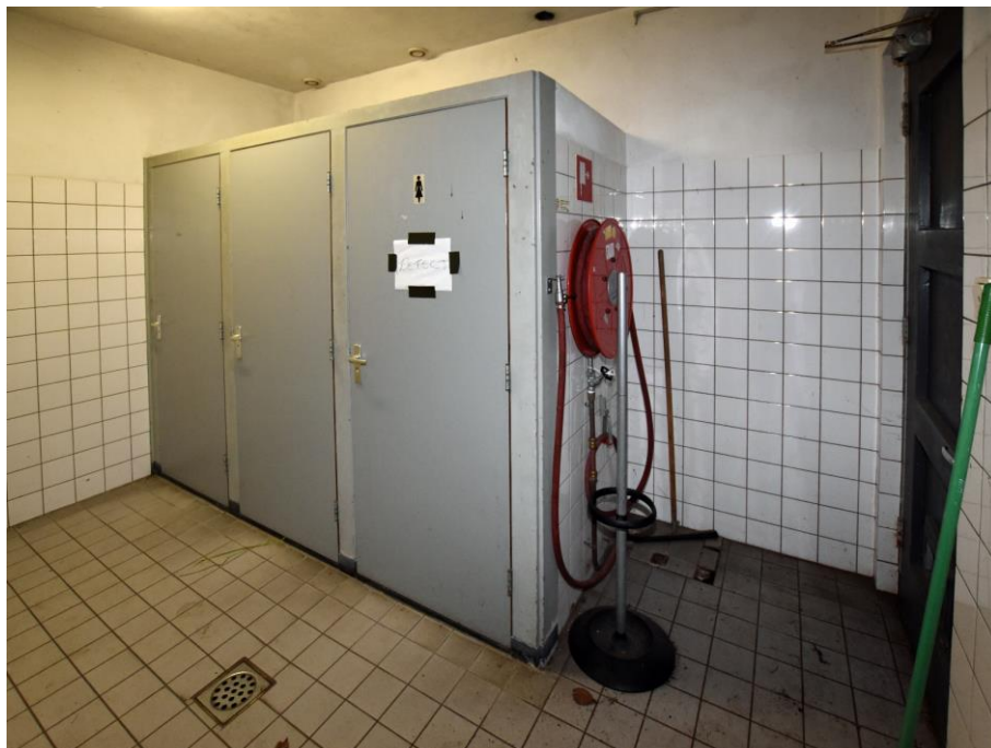
Gebouw 10, ruimte 4. Overzicht van het voormalige toilet voor officieren en onderofficieren. De scheidingsmuren en kozijnen van de toiletten zijn nog oorspronkelijk, de deuren zijn vervangen.
