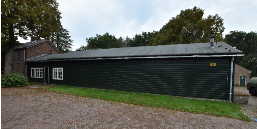
Gebouw 9. De noordgevel van de schijvenloods. Het rechter deel is omstreeks 1920 gebouwd. Links ervan het tussenlid dat in het eerste kwart van de 20ste eeuw tot stand is gekomen.
