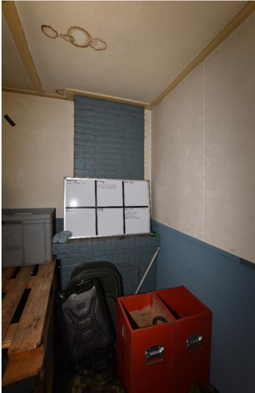
Gebouw 11, ruimte 011. In de zuidoosthoek van het vertrek bevindt zich een eenvoudige bakstenen haardpartij, die vermoedelijk uit de bouwtijd stamt. Het metselwerk ervan is inmiddels grijs geschilderd. De onlogische plaatsing in een uitbouw van het vertrek is het gevolg van een wijziging van de oorspronkelijke indeling van de barak bij de verbouwing rond 1967
