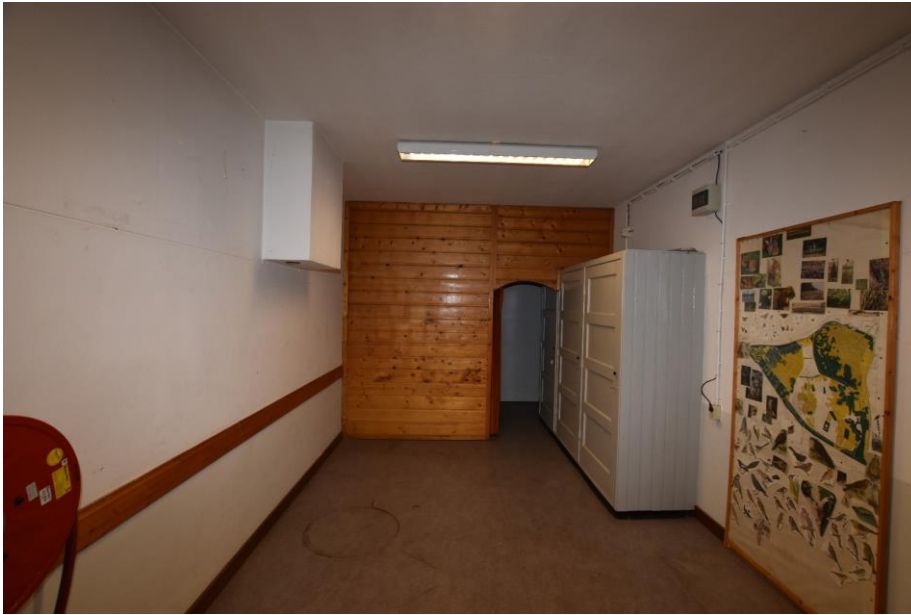
Gebouw 10. Overzicht van ruimte 1 gezien in oostelijke richting. Dit was oorspronkelijk een magazijnruimte met uitgiftebalie. Hiervan rest nog het drietal kasten rechts op de foto. De andere onderdelen, zoals stellingen, zijn inmiddels verwijderd. De houten wand in het midden van de foto is meer recent aangebracht om in de ruimte erachter een keukentje onder te brengen.
