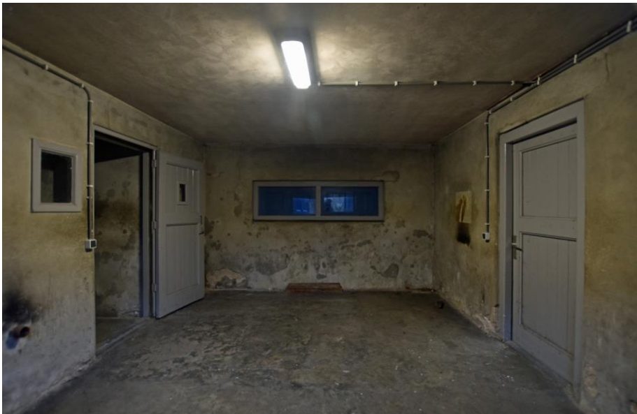
Gebouw 14, ruimte 02. Overzicht van de maskeroefenruimte, gezien naar het westen.
