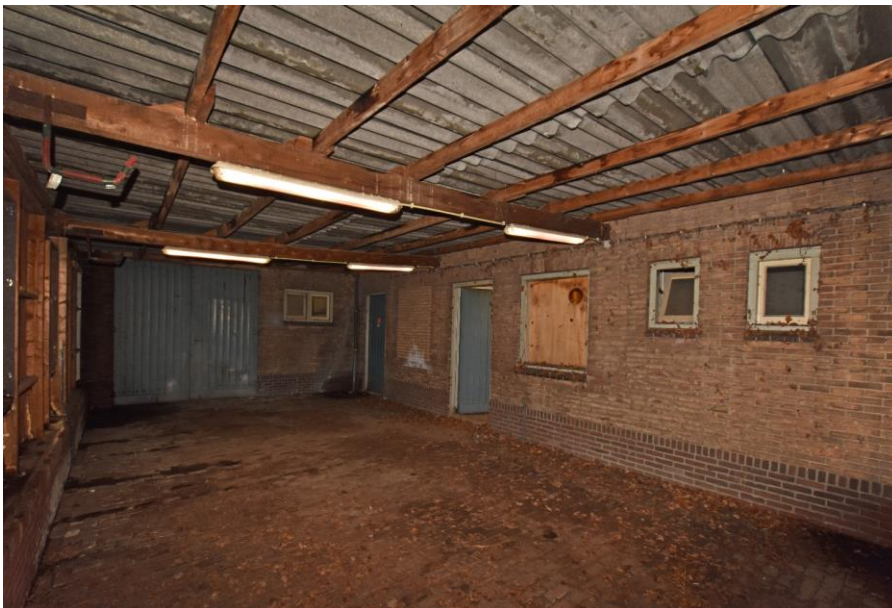
Gebouw 10, ruimte 7. Overzicht van deze naderhand aangebouwde ruimte, gezien in zuidwestelijke richting. De dakconstructie bestaat uit gordingen, die op een viertal dwarsbalken zijn gelegd. Op de gordingen rusten golfplaten. Rechts is de achtergevel van de materieelloods zelf te zien. Aanpassingen binnen het gebouw hebben ertoe geleid dat één vensteropening is dichtgemetseld en een andere met een plaat is afgesloten. Links van het midden van de foto zijn oorspronkelijke toegangsdeuren tot de materieelopslag te zien (houtopslag in ruimte 2).
