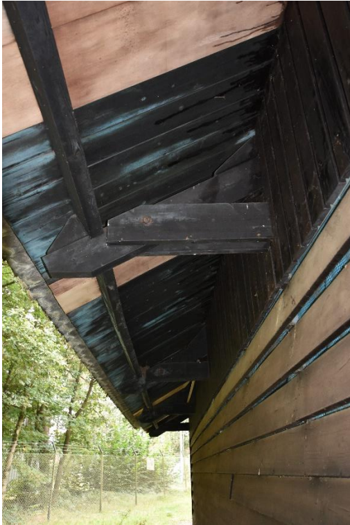
Gebouw 12. Detail van de doorstekende kapconstructie. De twee trekplaten en het tussen geklemde spantbeen zijn door middel van een bout met elkaar verbonden. Rechts is de oorspronkelijke verticaal uitgevoerde beplanking zichtbaar.
