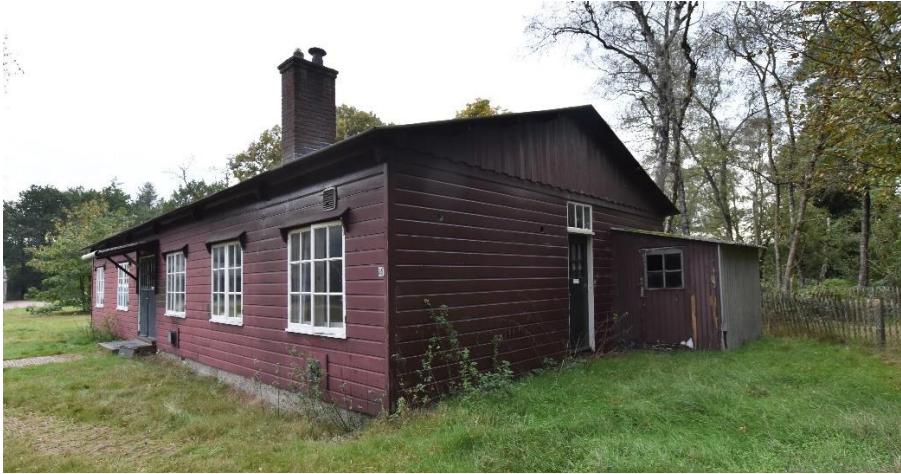
Gebouw 11. De loods gezien vanuit het noordoosten, met rechts de tegen de noordgevel geplaatste aanbouw, die uit het derde kwart van de 20ste zal stammen. De uitbouw zal voor opslag zijn gebruikt. Op het dak van de loods is de grote schoorsteen van de keukenschouw te zien.
