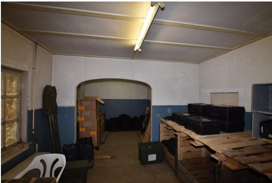
Gebouw 11, ruimte 011. Overzicht van het vertrek in noordelijke richting. De wanden en plafonds van deze ruimte en de naastgelegen ruimte 011A zijn afgewerkt met zachtboard. Dit zal bij de verbouwing in de jaren zestig zijn aangebracht.
