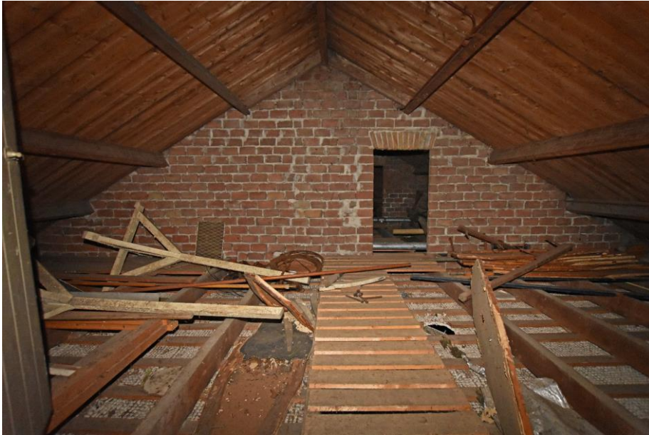
Gebouw 10, zolder zuidvleugel. Zicht op één van de half steens zware scheidingsmuren. Het metselwerk is in halfsteens verband gemetseld. De onregelmatigheden links van de deuropening zijn het gevolg van het rookkanaal aan de andere zijde van de muur. Op de zolderbalken liggen onderdelen van de schietbanen.
