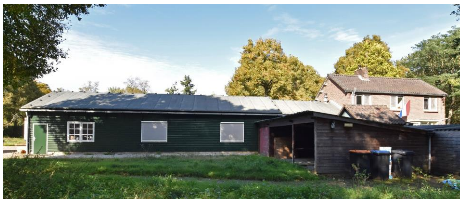
Gebouw 9: Schijvenloods annex woning.
