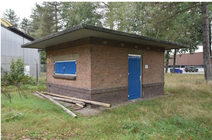
Gebouw 14. Overzicht gezien vanuit het noordoosten. Te zien is dat ook bij deze gevel de ventilatieopening onder de dakrand zijn dichtgezet.
