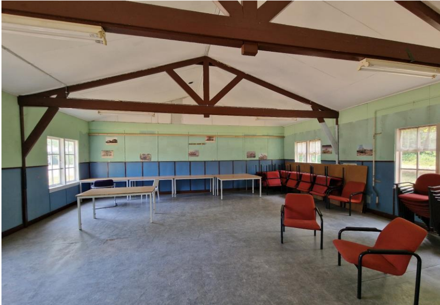
Gebouw 11, ruimte 009. Overzicht van de kantine gezien naar het zuiden. De wandafwerking met zachtboard zal bij de verbouwing rond 1967 tot stand zijn gekomen. Ook de zoldering is met zachtboard afgewerkt. (foto M. Greil, RVB)
