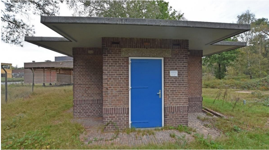
Gebouw 14. De zuidgevel van het gebouw. Aan de bovenzijde van de gevel is te zien dat de beide ventilatieopeningen in de uitbouw nog functioneel zijn. De beide openingen van de 'gaskamer' zelf zijn dichtgezet. Deze zullen oorspronkelijk de ruimte boven het plafond hebben geventileerd.
