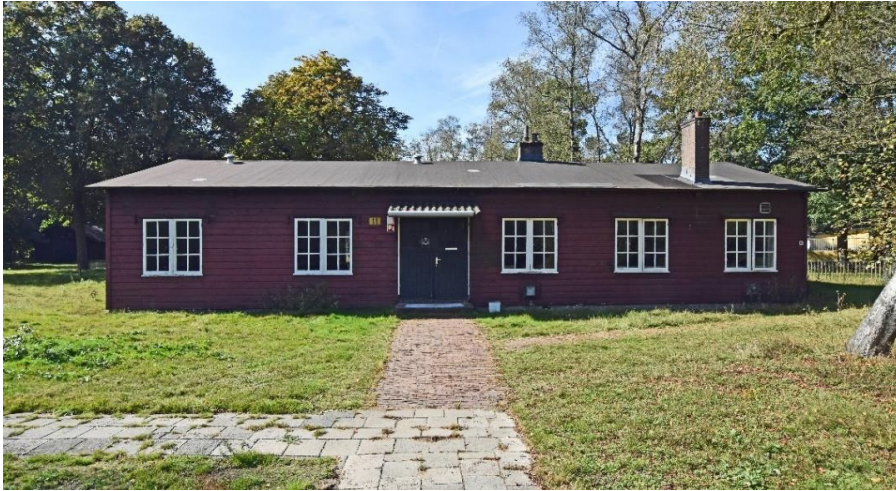
Gebouw 11. Overzicht van de oostgevel.
