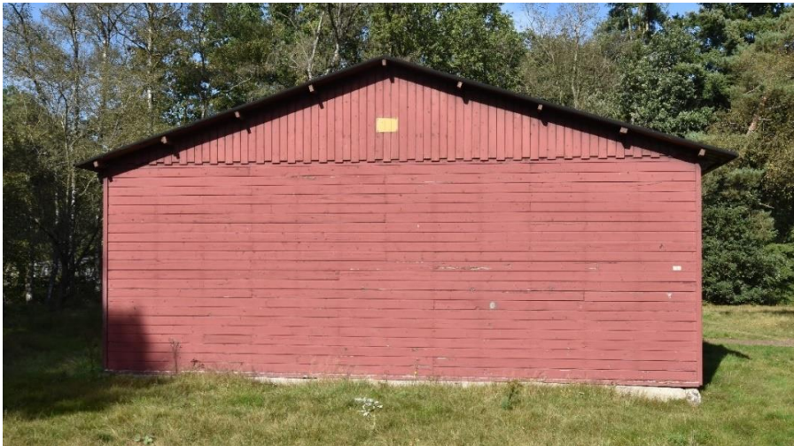
Gebouw 11. Overzicht van de zuidgevel. De gevel is tot stand gekomen, nadat het meest zuidelijke deel van de loods was gesloopt.
