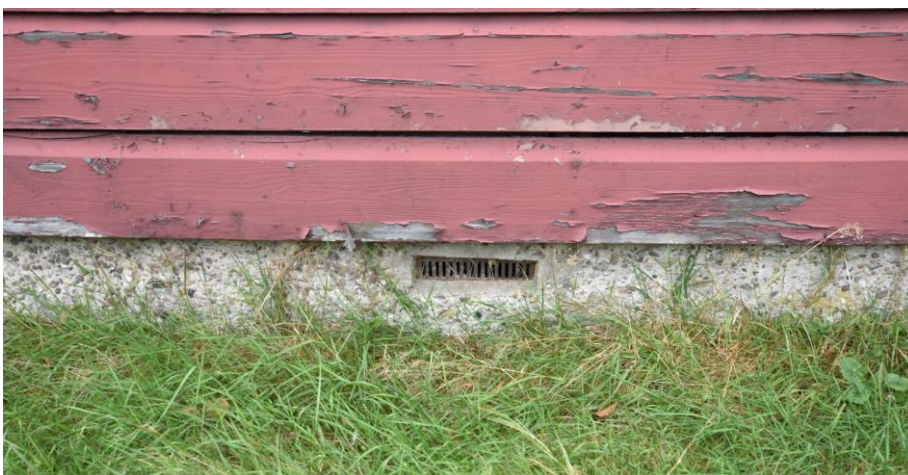
Gebouw 11. Detail van de betonnen voetmuur van de loods, met één van de ventilatieroosters die de kruipruimte ventileren.
