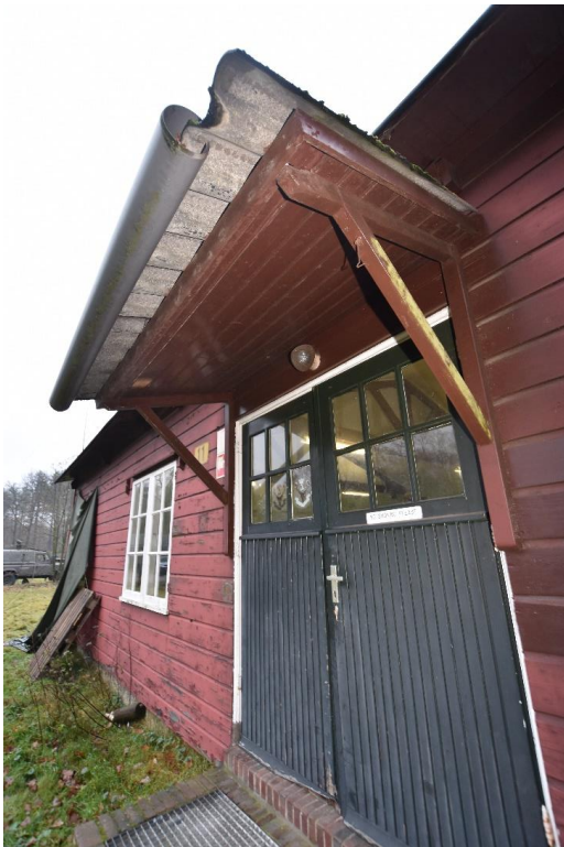
Gebouw 11. Detail van de entree in de oostgevel. De huidige deuren zullen bij de verbouwing van omstreeks 1967 zijn geplaatst. Of het afdak boven de toegang nog tot de oorspronkelijke opzet behoort of een latere toevoeging is behoeft nog nader onderzoek.
