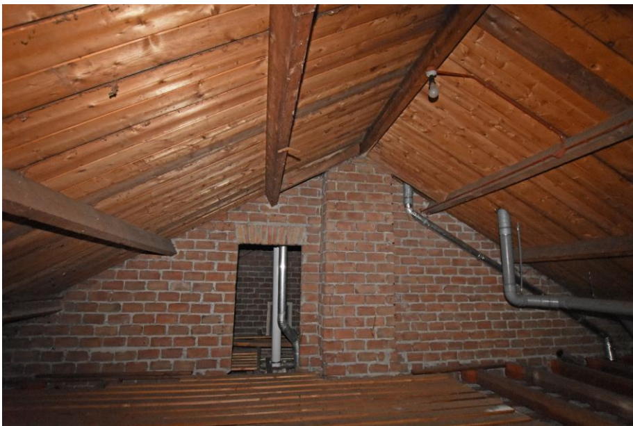
Gebouw 10, zolder noordvleugel. Eén van de scheidingsmuren in het noordelijke deel van de zolder. De opzet is identiek aan die aan de zuidzijde. Rechts naast de deur is één van de rookkanalen zichtbaar. De metalen pijpen zijn relatief recent en behoren bij verwarmingsinstallaties en luchtafzuigingen.
