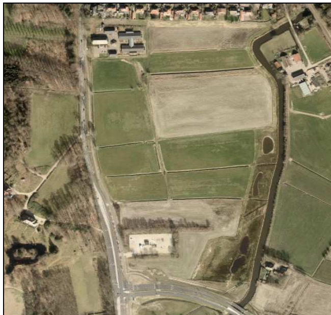
Afbeelding - Luchtfoto huidige situatie
