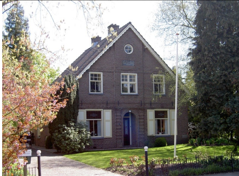
Hamersveldseweg 69: Woning, tuinhek en schuur
