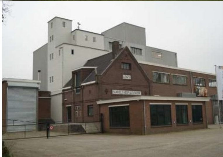
Hamersveldseweg 138: Coöperatiegebouw, kolenloods, grasdrogerij en spoorlijn bij perron
