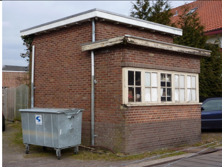
Hessenweg bij 208: weeghuisje/ transformatorhuisje en weegbrug
