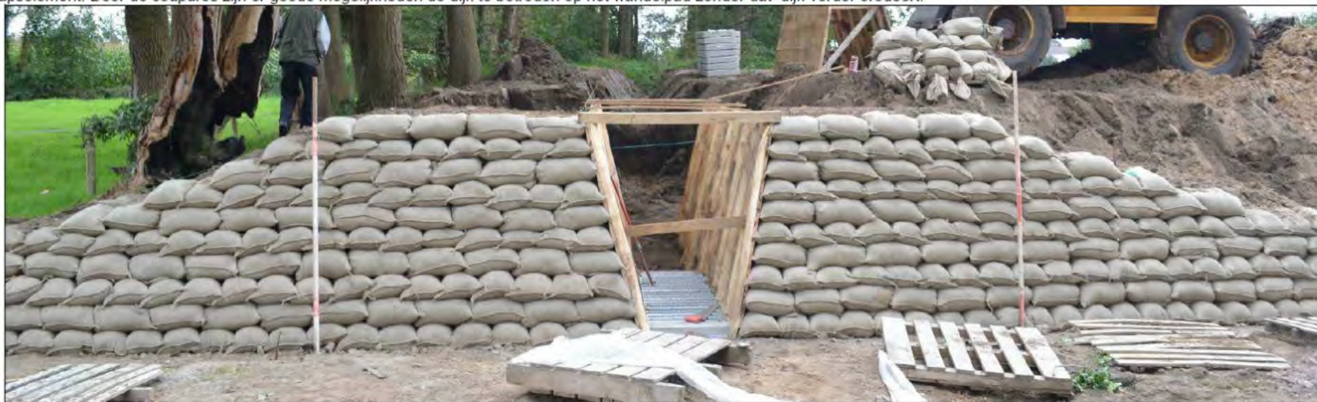
Foto 8: Voorbeeld van een betonzakkencoupuremuur op de Asschatterkeerkade met in het midden de opening voor de voetgangsofgang.
