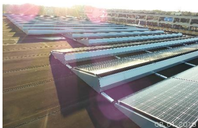
Plaatsing van de zonnepanelen op het dak van de sporthal.
