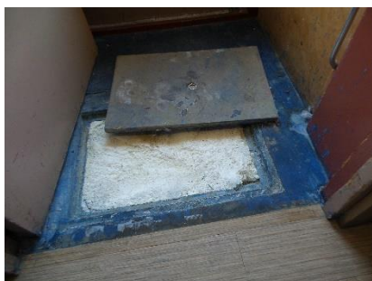
Aangebracht isolatiemateriaal
