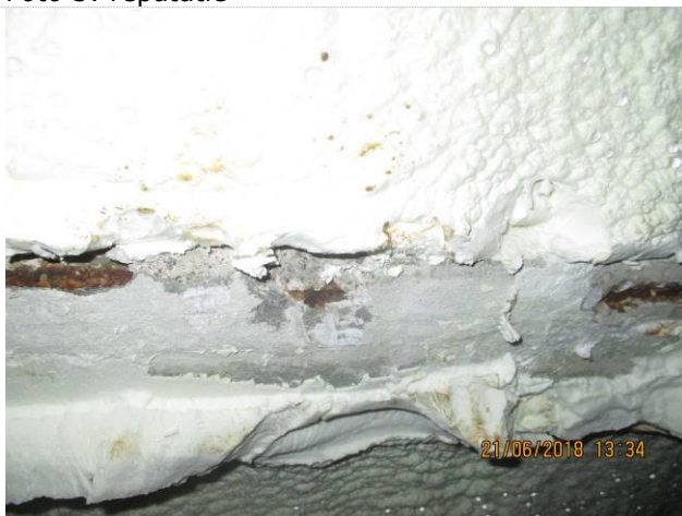
Foto 5: corroderende wapening onder reparatie
