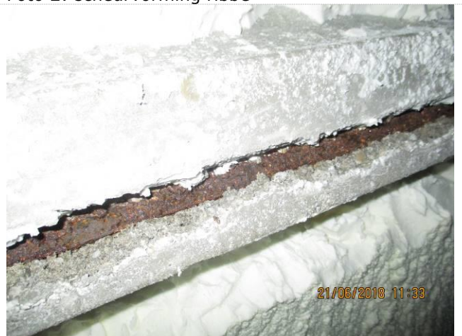
Foto 4: open gehakte scheur
