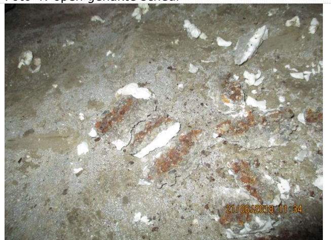
Foto 6: carbonatatie sporen op weg gehakt beton
