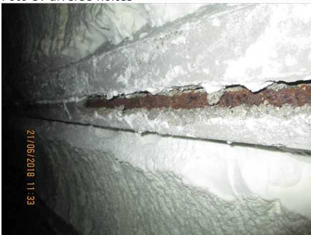
Foto 5: corroderende wapening
