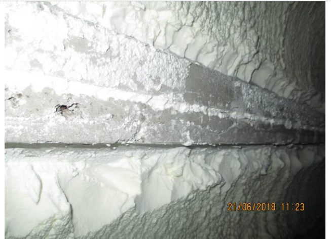
Foto 2: scheurvorming ribbe
