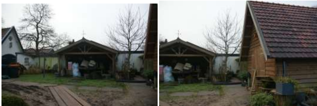
Afbeelding1: bestaande situatie gezien vanaf de woning / nieuwe uitbouw. De witte muur rechts naast het overdekte terras is de scheidsmuur tussen de twee percelen. Het witte gebouw op de linker foto en het houten gebouw op de rechter foto zijn de bestaande (vrijstaande) bijgebouwen op het perceel.
