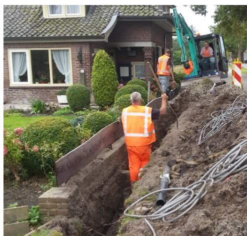
Figuur 13: aanleg drukriolering Arnhemse weg
