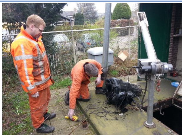
Figuur 25: Onderhoud rioolgemaal Leusden-Zuid
