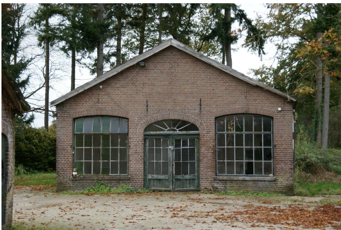
Afbeelding 5: de bestaande Oranjerie
