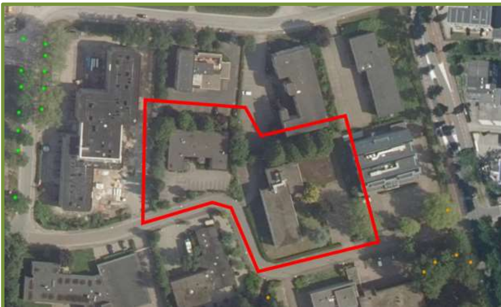
Bitumen daken. RAP Gebiedsontwikkeling
