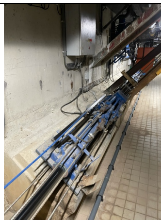
28 Zeer verouderde (oorspronkelijke) aandrijfunit van de beweegbare bodem.
