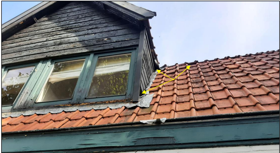
Figuur 4.2 Voorbeeld van voor huismus geschikte invliegopeningen bij het dat van het woonhuis. Bron foto: Ecogroen.
