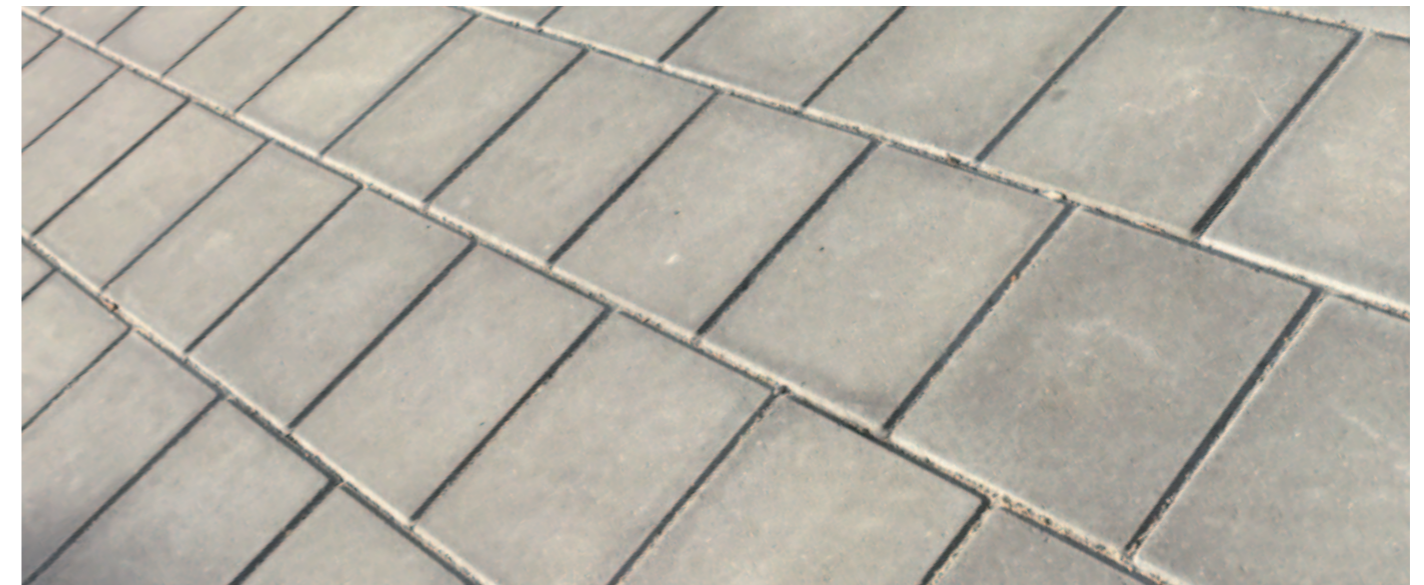
Betontegel 30x30 halfsteensverband.
