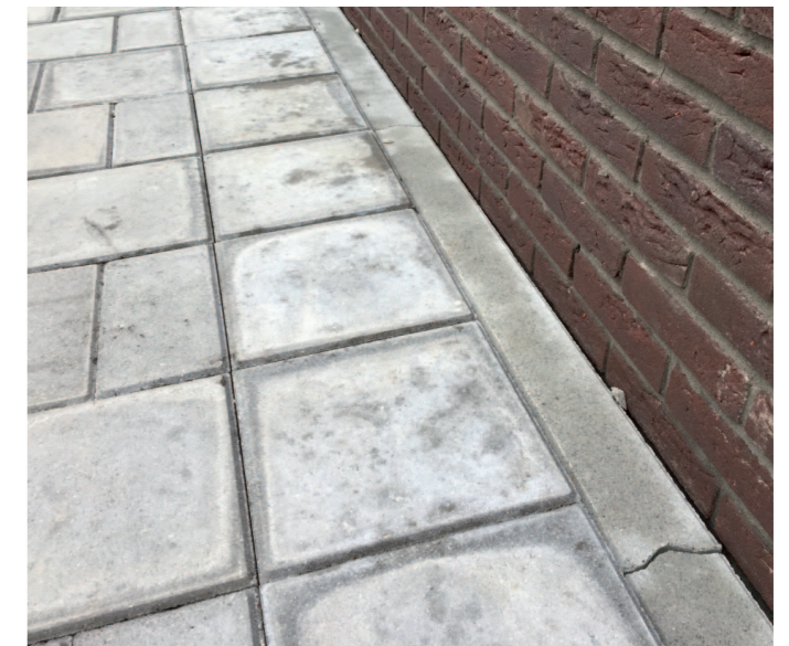
Opsluitband 10x20 met streklaag tegel 30x30.
