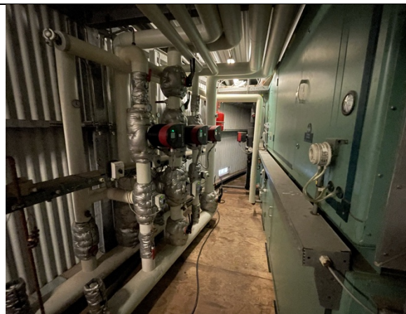
30 Zeer oude (niet gerenoveerde) LBK. Deze is economisch afgeschreven.
